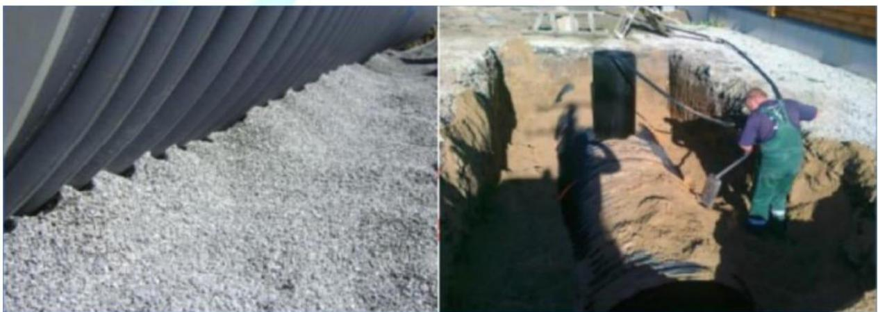
شكل ۴: نمونه ای از پر کردن اطراف مخزن
